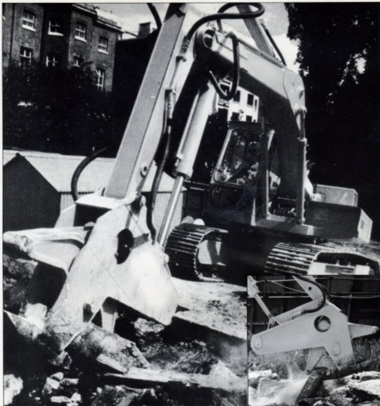
英国での道路解体作業現場
